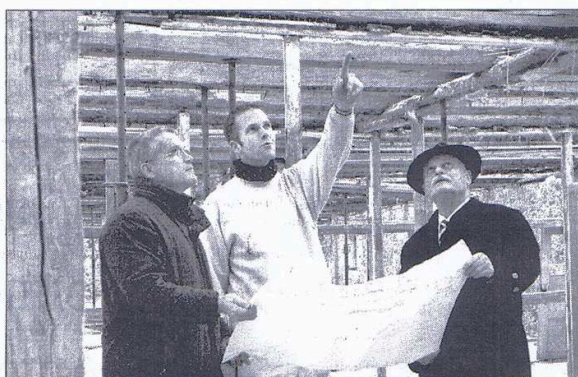
Geschäftsführer Werner Reinhuber (v.l.), Robert Göttsch, leitender Mitarbeiter, sowie Jürgen Menzer vom Stiftungsrat und Vorstand beraten im entkernten zweiten Stallgebäude. Das Amt für ländliche Neuordnung in Kamenz fördert den Wiederaufbau des Rittergutes Limbach.
