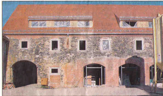
Ende 2007 soll das Seminargebäude im Rittergut Limbach fertig sein.
